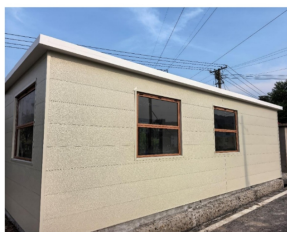
(d) 济南装配式咖啡屋工程
