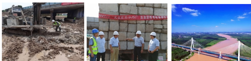
图 27 现场施工、注浆效果对比试验和建成后效果
