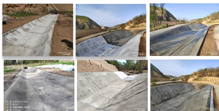
图 18 水泥毯沟渠铺设
